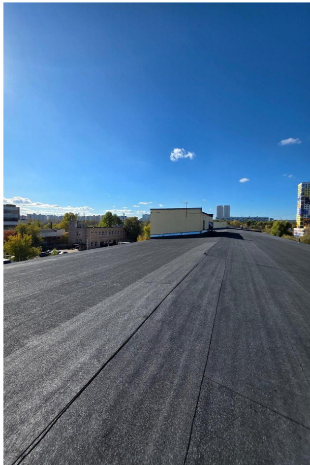
Протяжённая часть кровли
